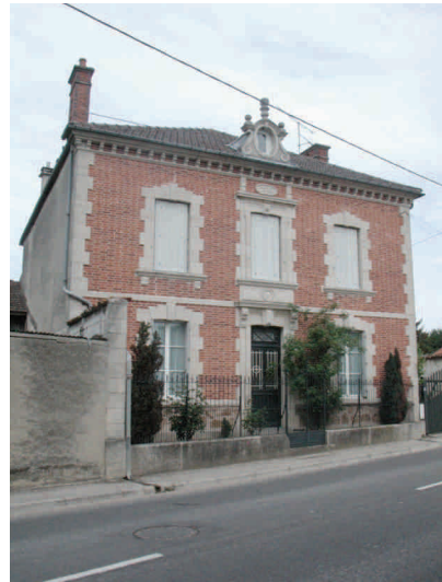
Muret surmonté d'une grille
