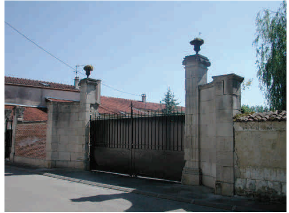
Mur de clôture agrémenté d'un portail
