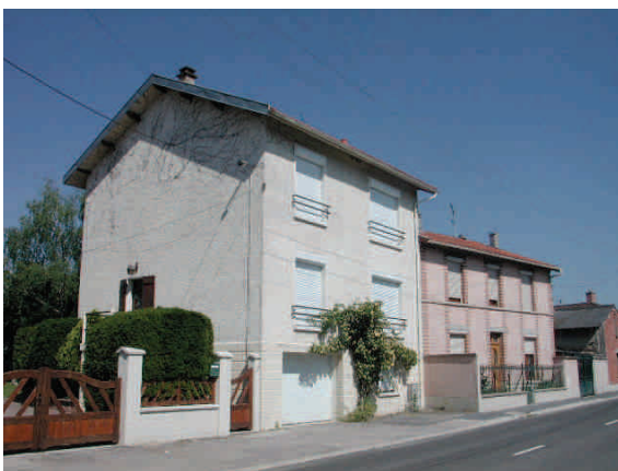
Construction 1950 : garages en rez-de-chaussée et logements à l'étage ; Construction 1930 : 3 travées et muret
