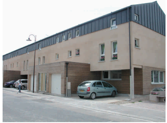
Construction récente implantée à l'alignement, services en rez-de-chaussée, logements à l'étage
